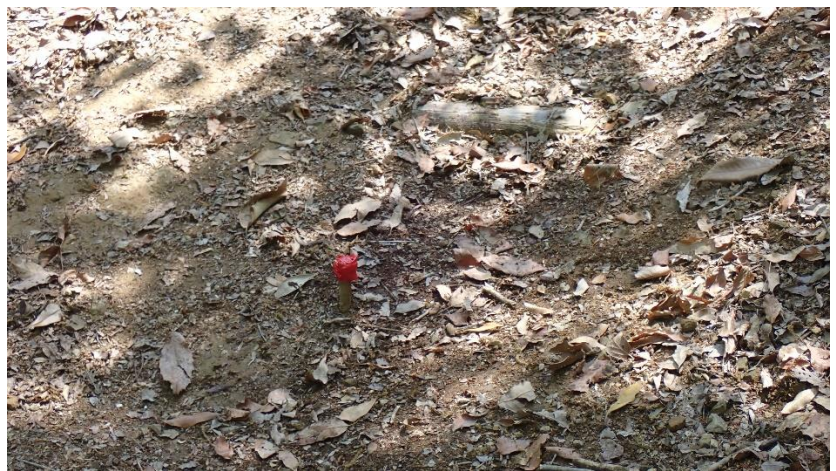
飛び出したボルトに赤テープを巻く
